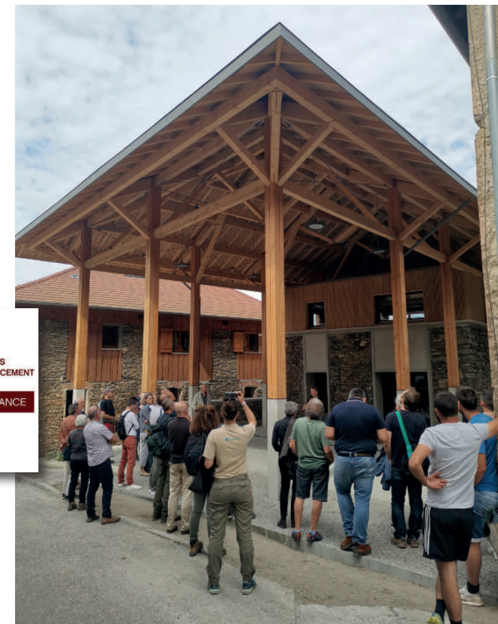
La nouvelle halle du Moutaret construite avec de l'épicéa scolyté
